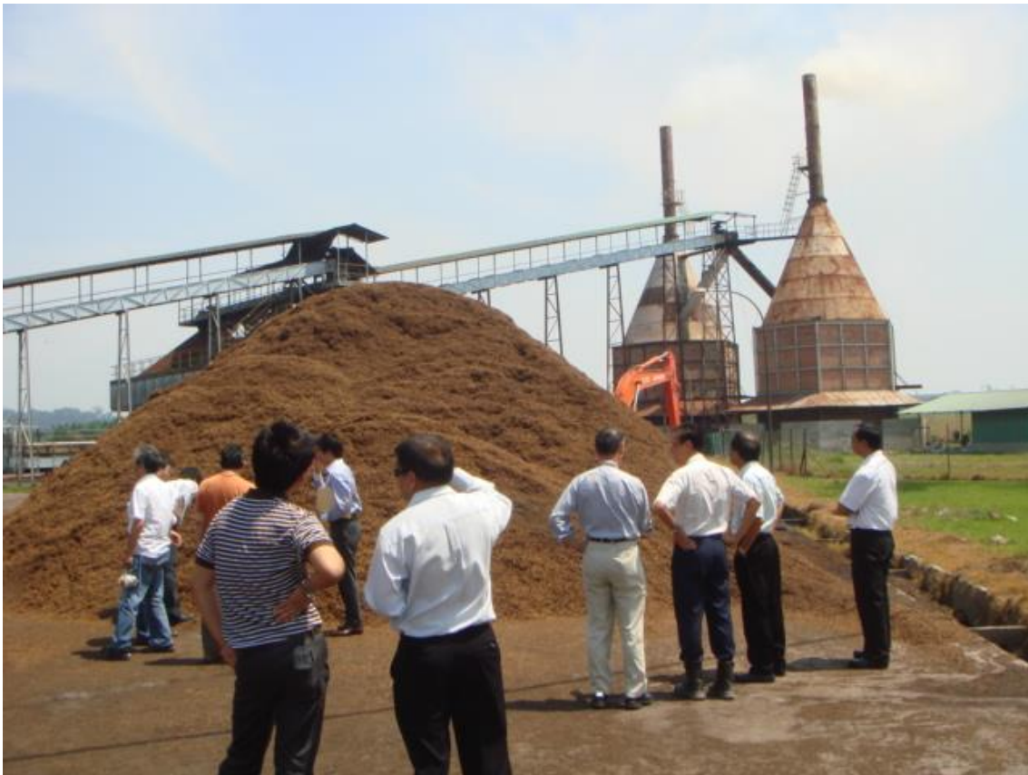
図 3-29 油やし搾油工場の EFB 焼却炉
