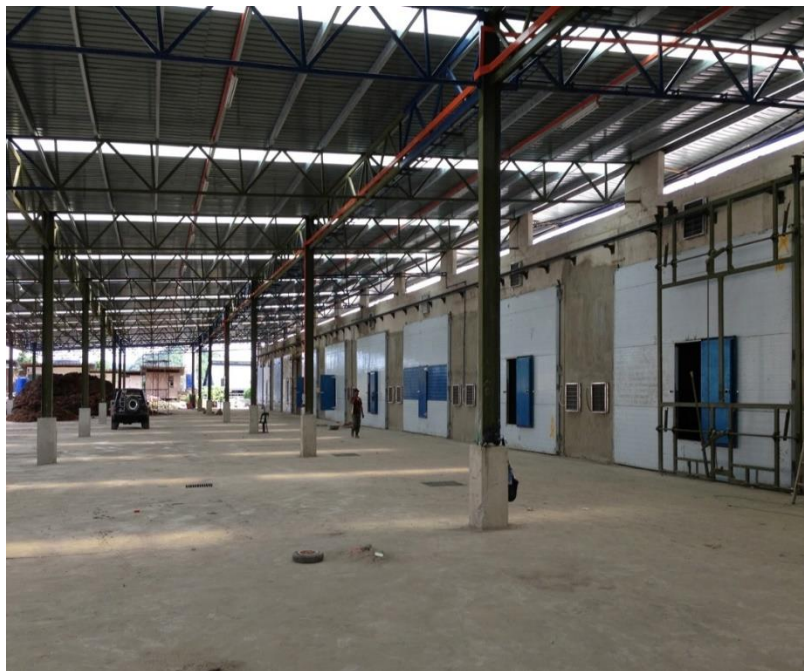
図 3-33 発酵処理チャンバー（14棟）と養生スペース（左手前）
