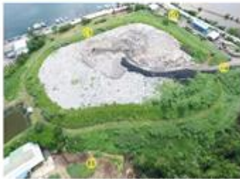
写真3-2-2 M-dock内のプラント候補地
