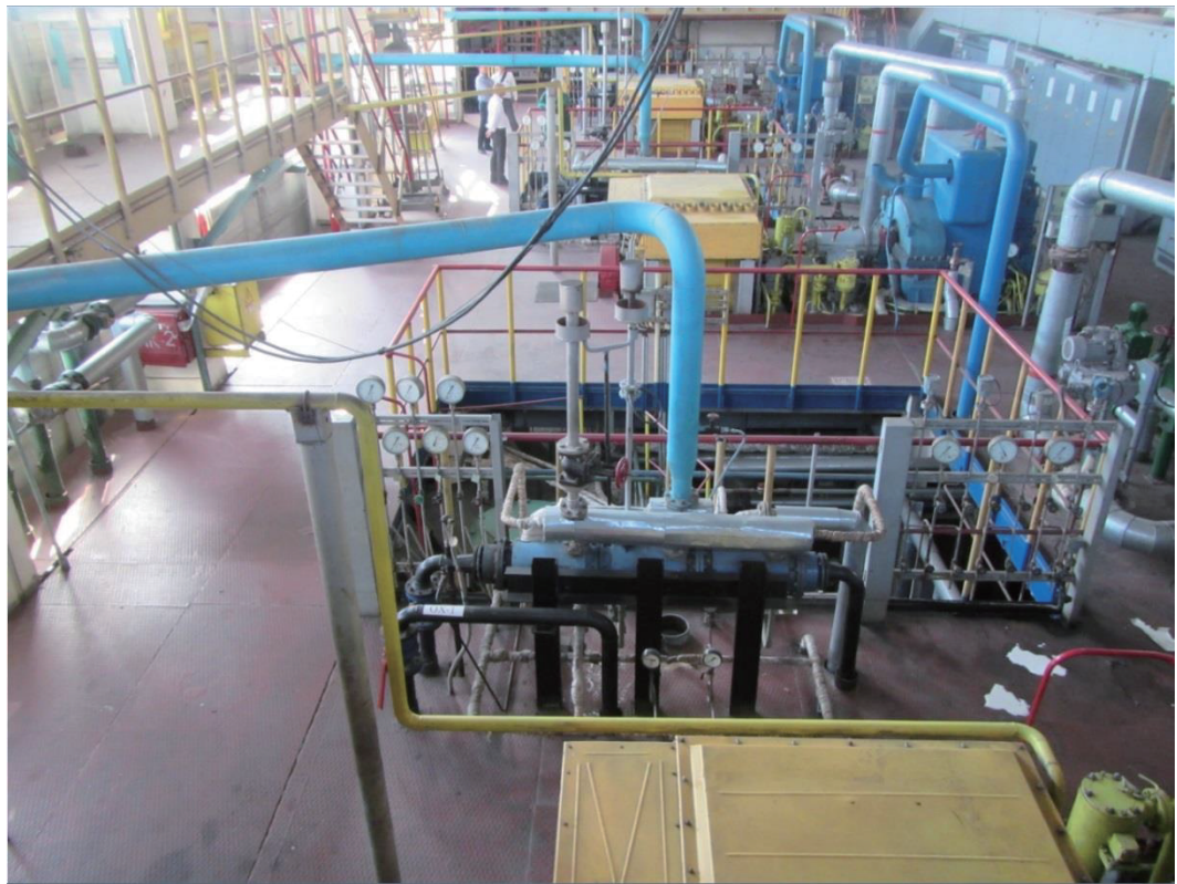
図 7-7 第2焼却工場発電ビル内
