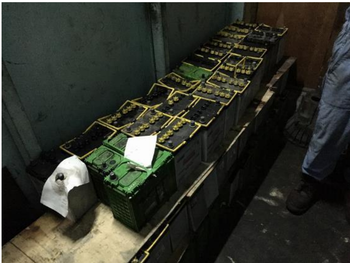
図 3-1 A プールの整備工場における廃鉛バッテリー保管状況
