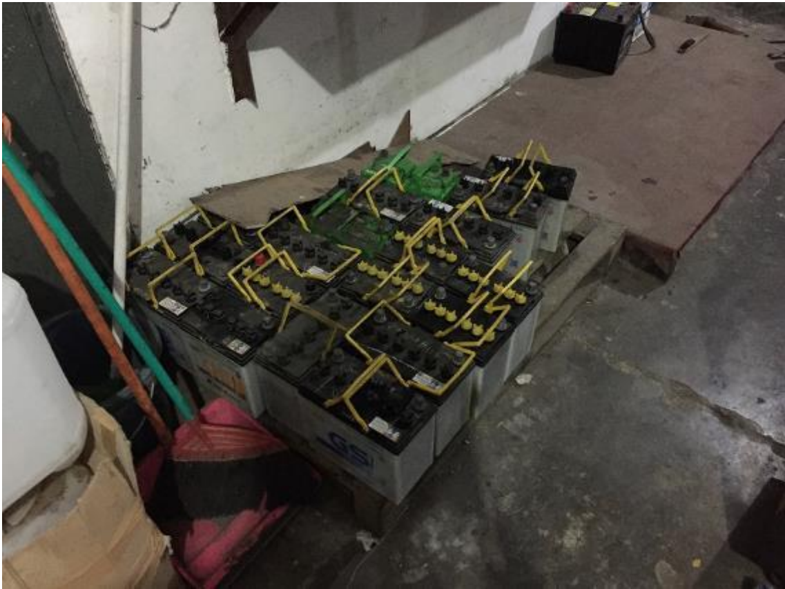
図 3-12 R プールの整備工場における廃鉛バッテリー保管状況
