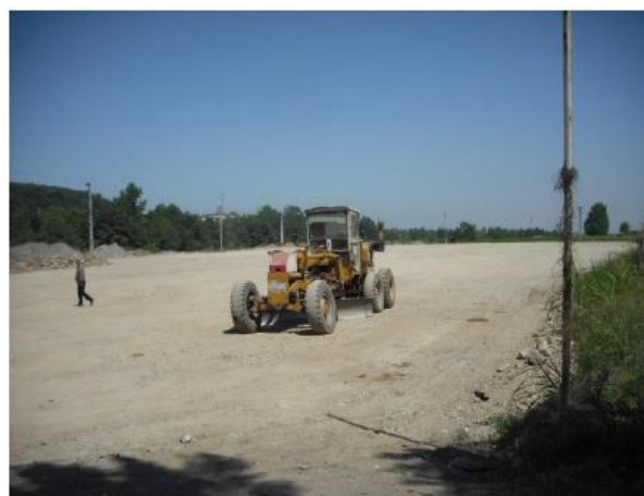
図 3-5 施設建設候補地（造成中）
