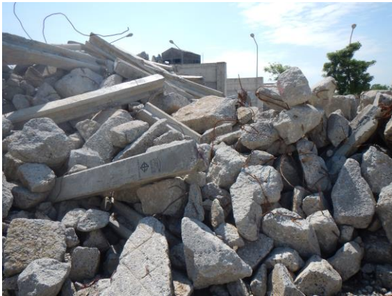
写真 4-3. コンクリート廃材置き場
