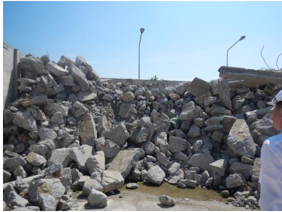
写真 4-2. コンクリート廃材置き場
