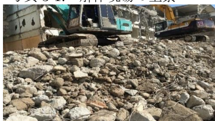
写真 3-3. 人頭大に小割した埋戻し材
