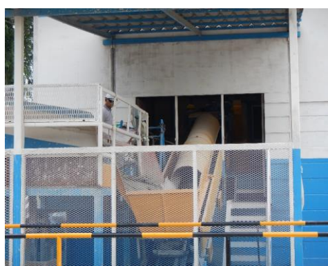
写真 4-8. 再生骨材プラント（L）の原料投入口
