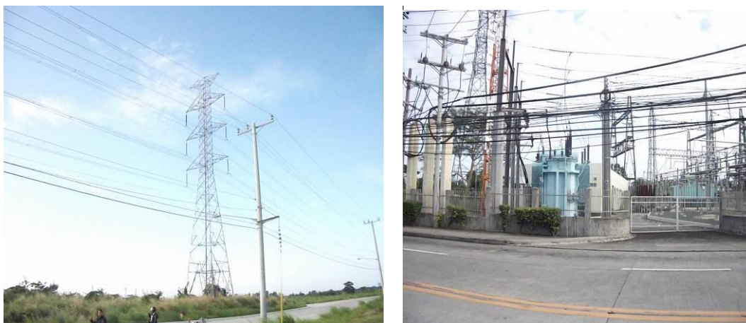
予定されるプラントより最も近いグリッド地点(左)と LTI 工業団地内の Meralco 配電設備(右)
