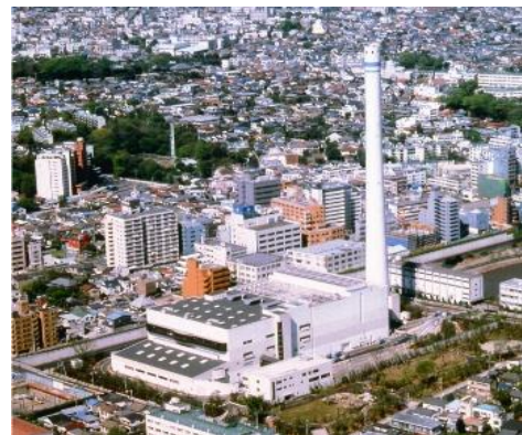
目黒清掃工場現地写真 （目黒清掃工場パンフレットより）
