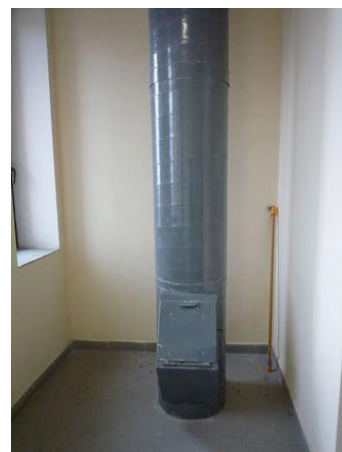
写真 2-2-1 集合住宅設置のダストシュータ
