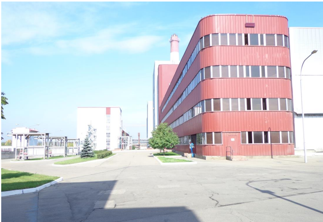
写真 5-2-2 モスクワ市南南東 No. 4 廃棄物処理施設
