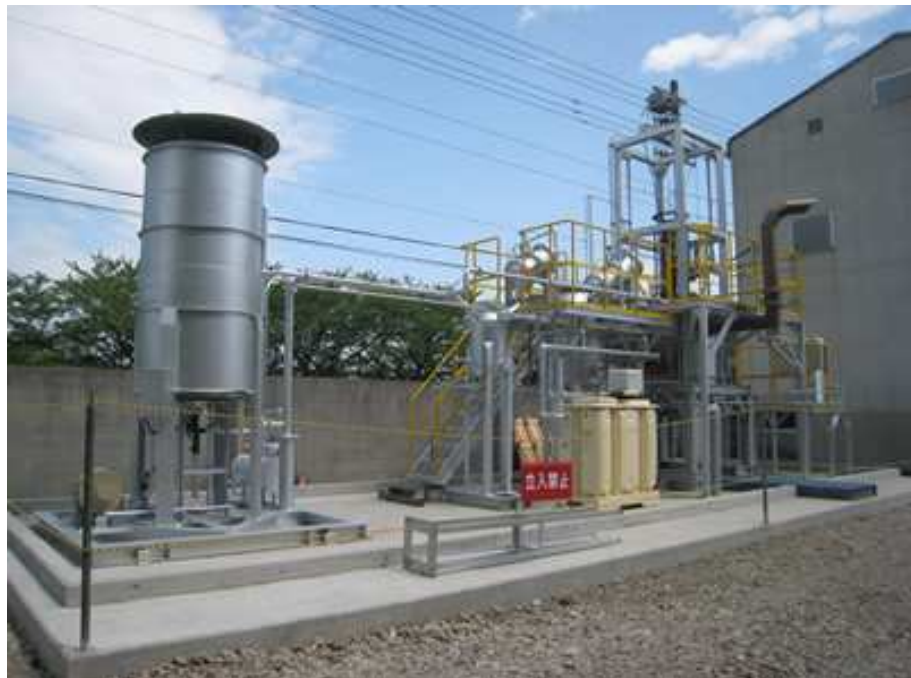
写真 8. 日本環境設計今治第二工場 油化実験装置(愛媛県今治市)
