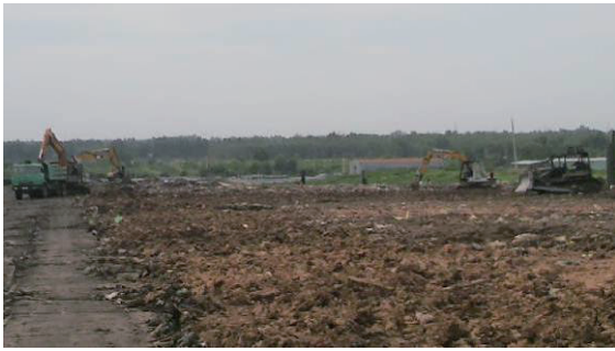
埋立作業状況
