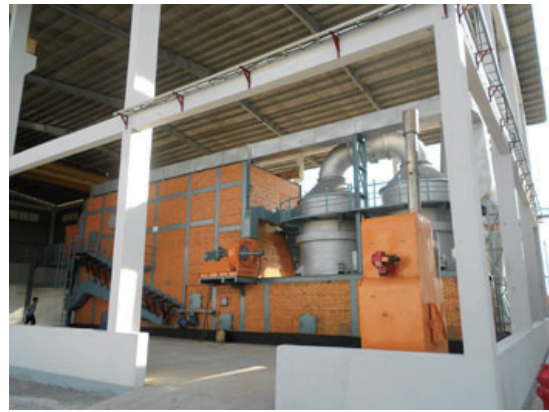
コンポスト工場内の焼却施設
