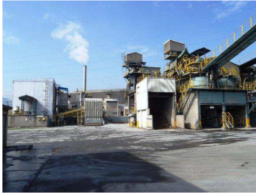
Photo.1-3 当社スラグ処理設備
