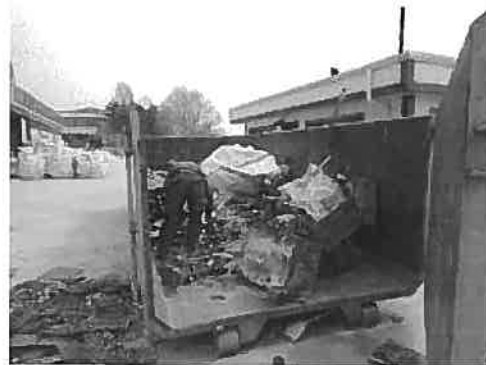
アームロール車用ボックスによる搬入
