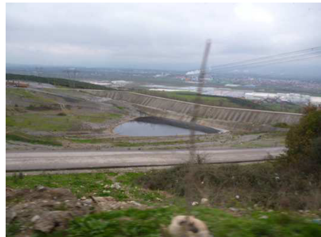
図 7-2-8 Solaklar 埋立処分場見学状況
