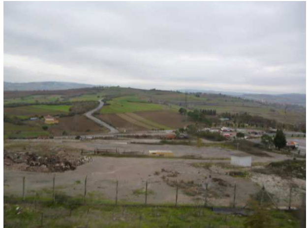
図 7-2-6 Solaklar 埋立処分場見学状況
