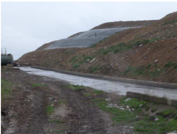
図 7-2-7 Solaklar 埋立処分場見学状況
