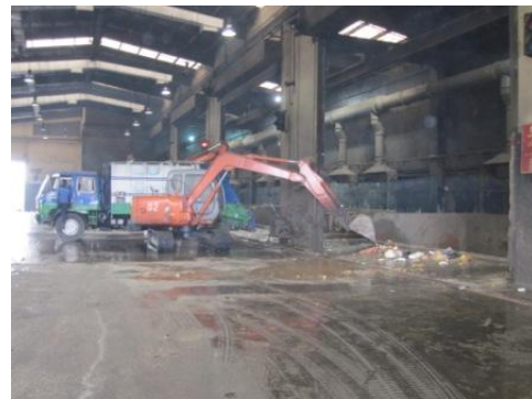
施設内部（投入口付近）
