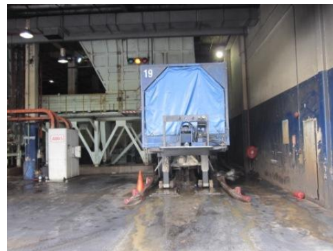
圧縮装置（施設外部から）
