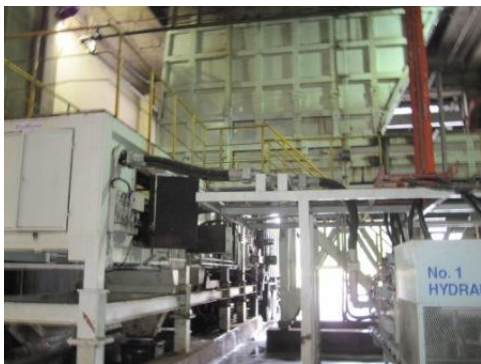
圧縮装置（施設内部から）
