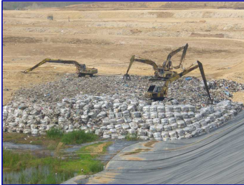
写真 3-5 パノムスーラカーム埋立処分場における埋立処分 (都市ごみはパッキング(比重: 1ton/m 3 )されたまま埋立処分されている。)
