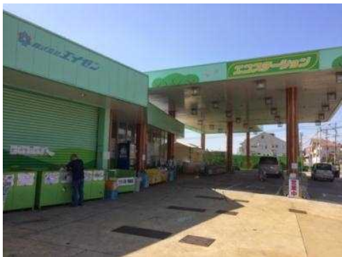
<ガソリンスタンドを改修したエコステーション>
