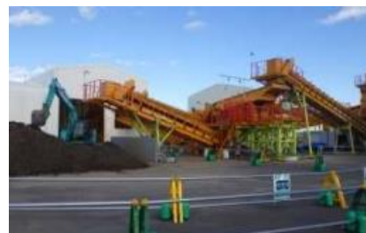
檜葉町の仮置場内破砕選別設備 出典：環境省
