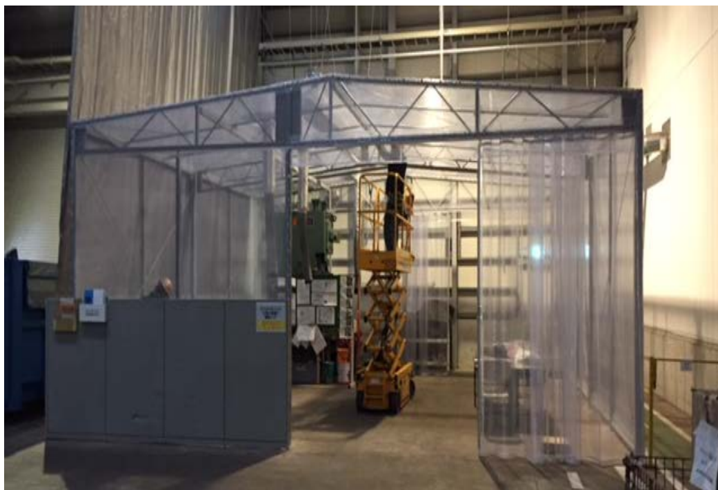
図表 1 工程づくり作業場(防塵膜設置)
