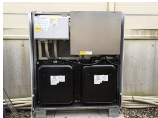
写真 2.2.7 LiB 蓄電池 (2) 内部構造
