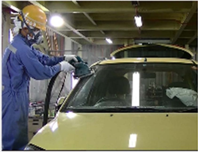
◆ダイヤモンドカッターでの解体
