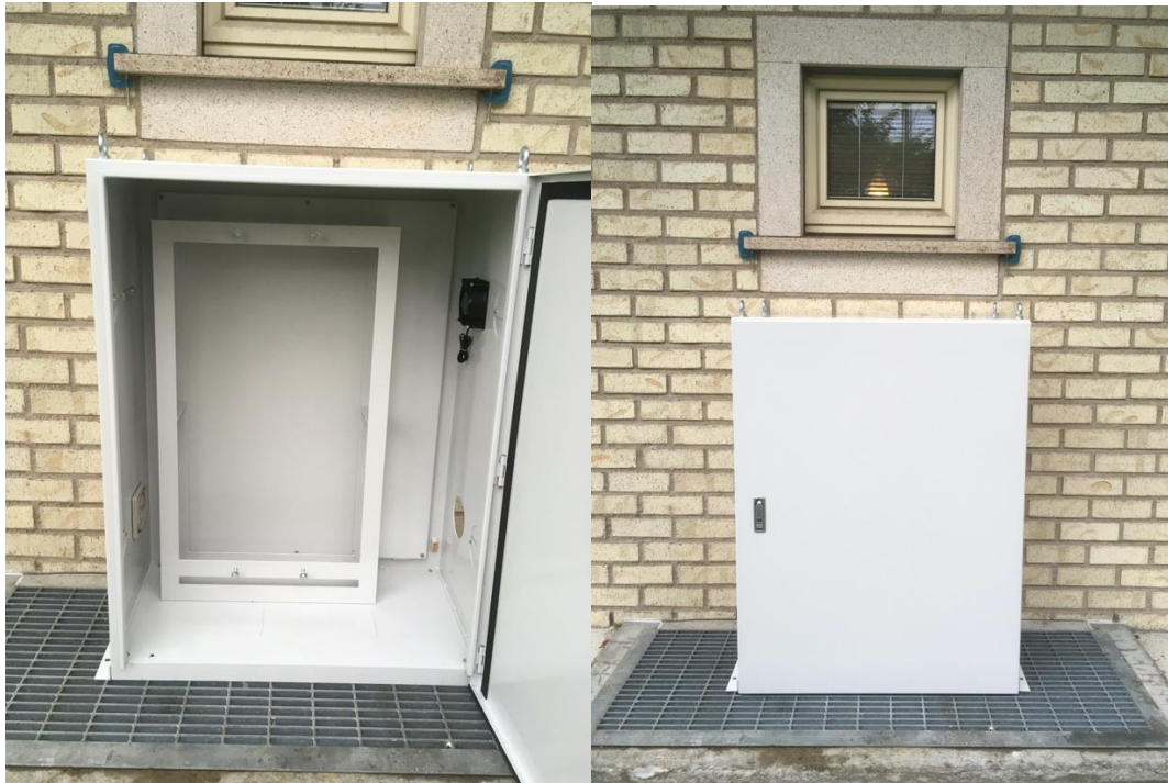
図 2-1-1-43. 屋外設置用 LiB スタビライザー筐体
