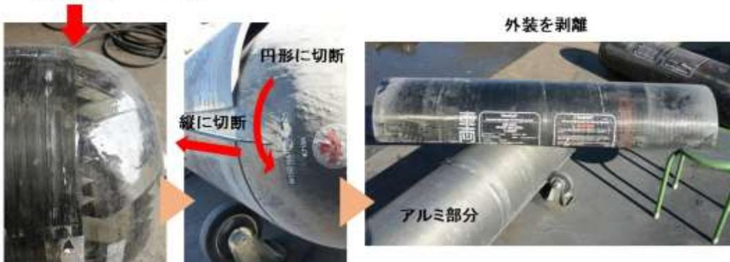
図 3.48 CNG ボンベ切断の手順
