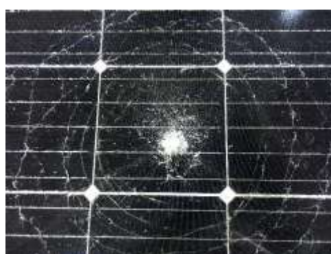
写真 3.1.4 カバーガラスの状態 (割れ有り)
