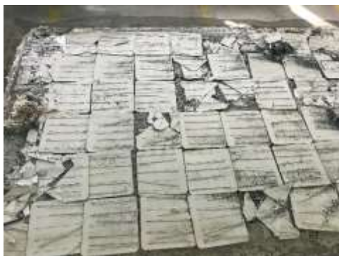
写真 3.1.5 焼成後のパネル外観①
