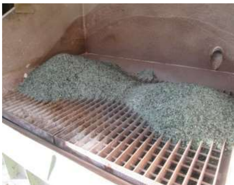
写真 3.5.4 貯蔵サイロへのカレット投入状況
