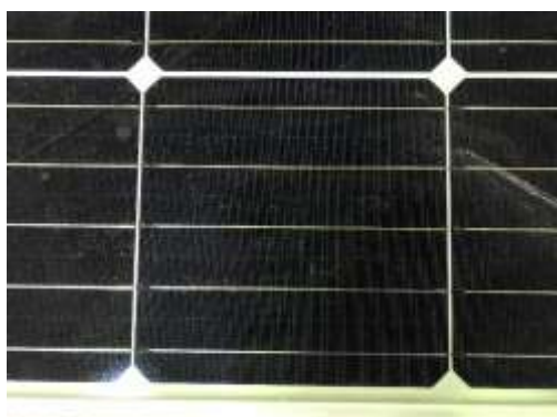
写真 3.1.3 カバーガラスの状態 (割れ無し)
