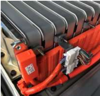
ユニットA内モジュール近影
