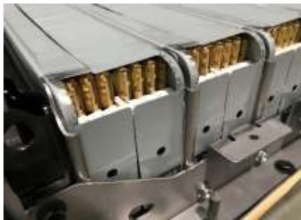
ユニットA内モジュール近影
