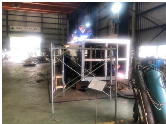
写真2-1-1-6 溶接作業状況
