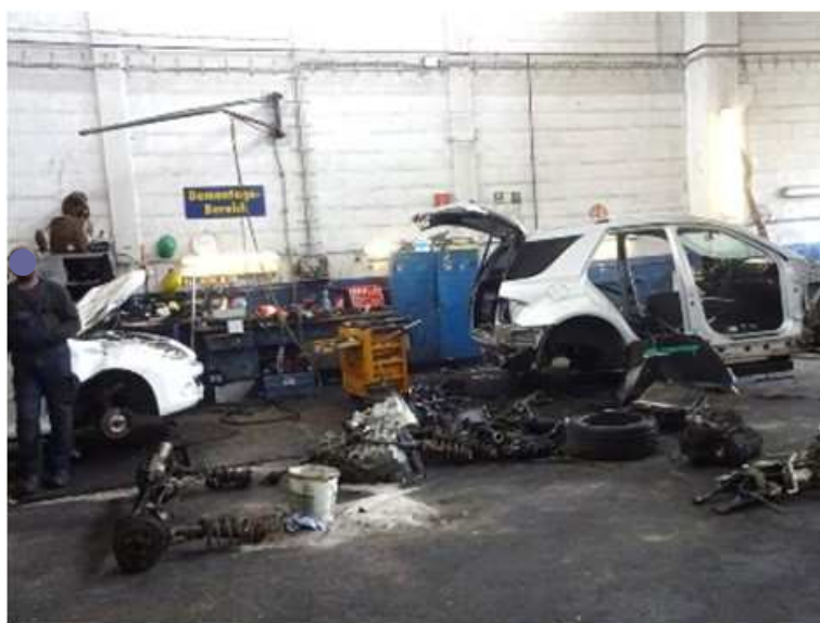
図 4.1.1.2.3 解体がほぼ終了した廃車ガラ
