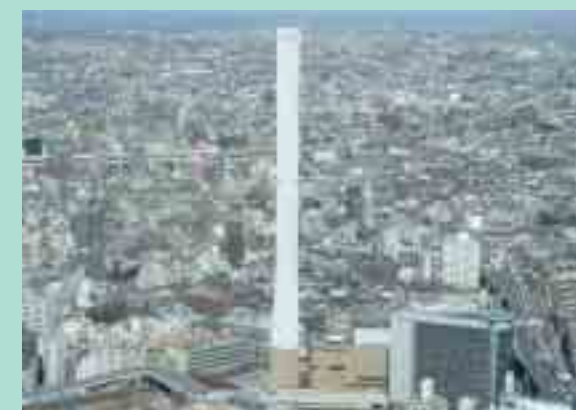
都市に設置された焼却施設
