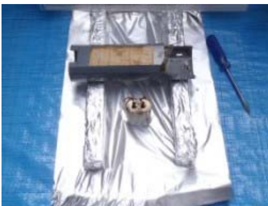
コンデンサ取り外し作業終了
