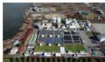
県有施設屋根貸し第1号 豊田終末処理場
