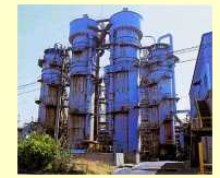
排煙脱硫装置
