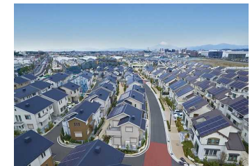
スマートタウンの戸建住宅
