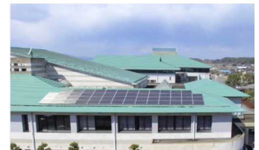
太陽光発電設備 (熊本県御船町)
