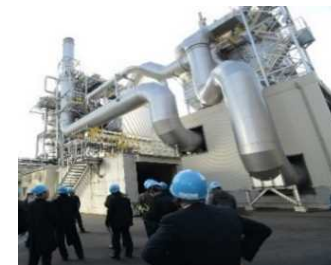
木質バイオマス発電所
