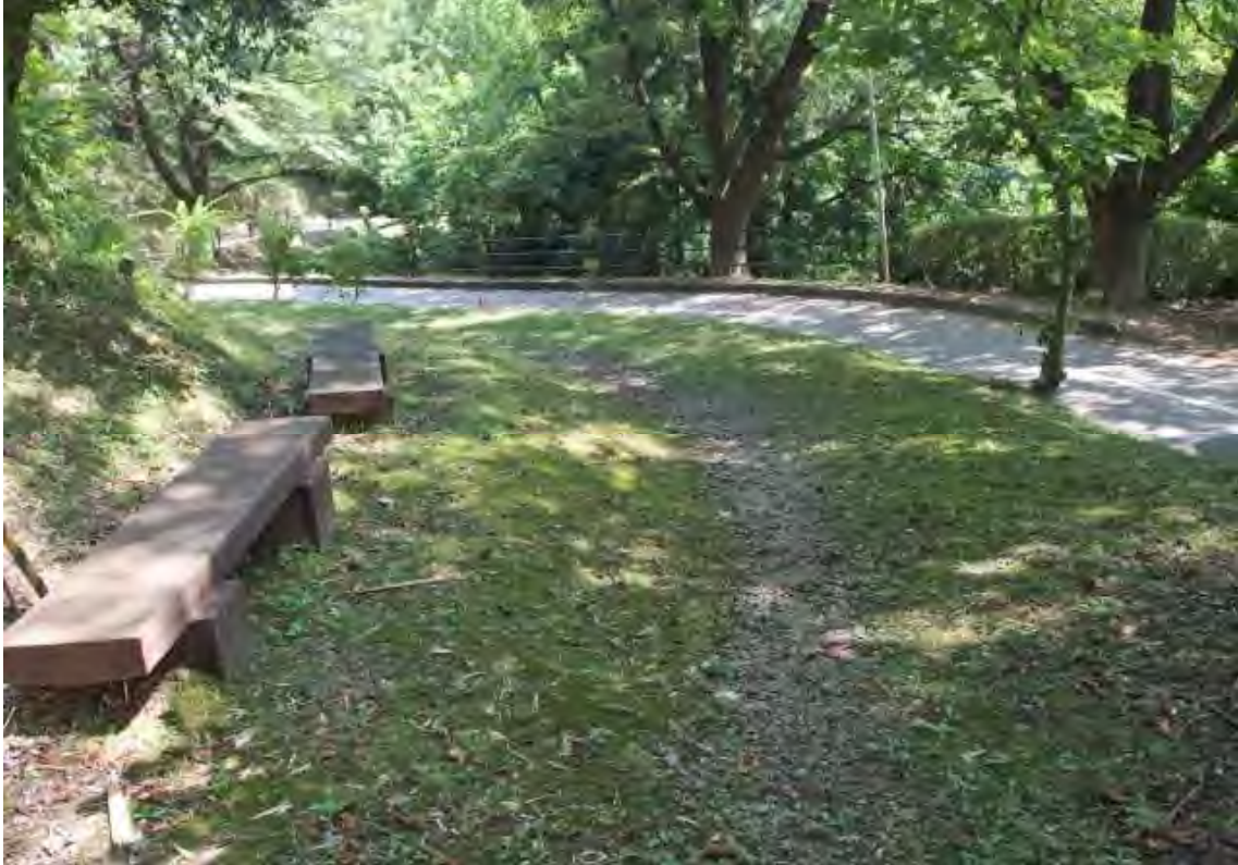
(写真1：遊歩道の状況)
