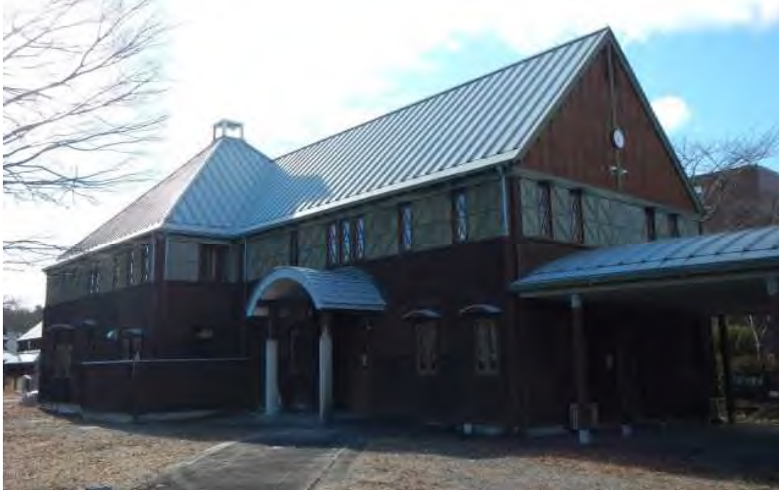
(写真1：周辺の状況(グリーンフィールド富岡))
