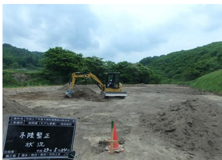
均平化(不陸整形)
