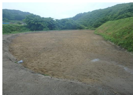
仕上がり状況(直後)
