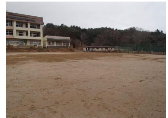
仕上がり状況
