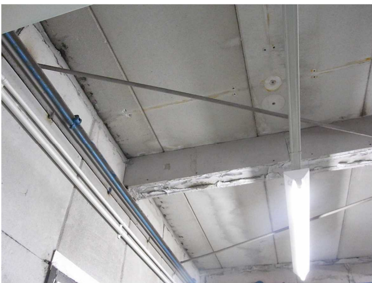
③石綿含有耐火被覆塗り材
