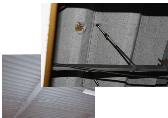
レベル2: 屋根用折板石綿断熱材
