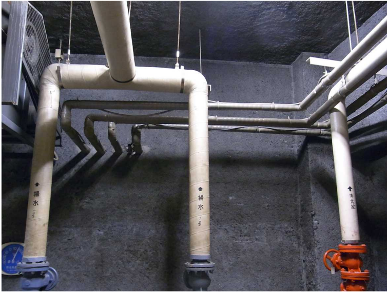
①吹付け石綿(クロシドライト)
