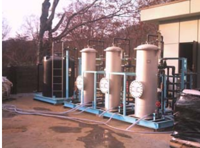
図 装置設置状況
