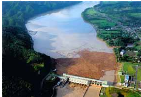
（台風に伴い、二風谷ダムに漂着した大量の流木）
