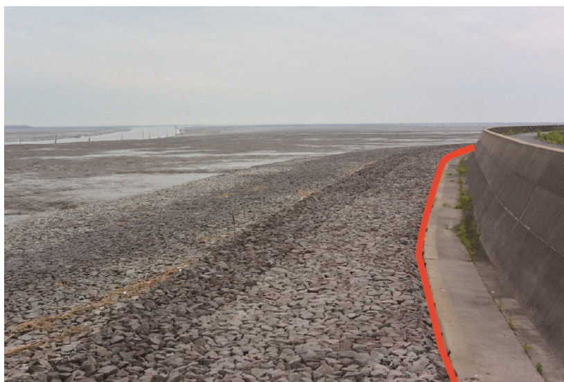
海岸防波堤（法尻）境界
