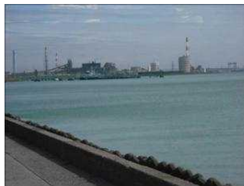
写真：千葉港（平成23年8月30日）
