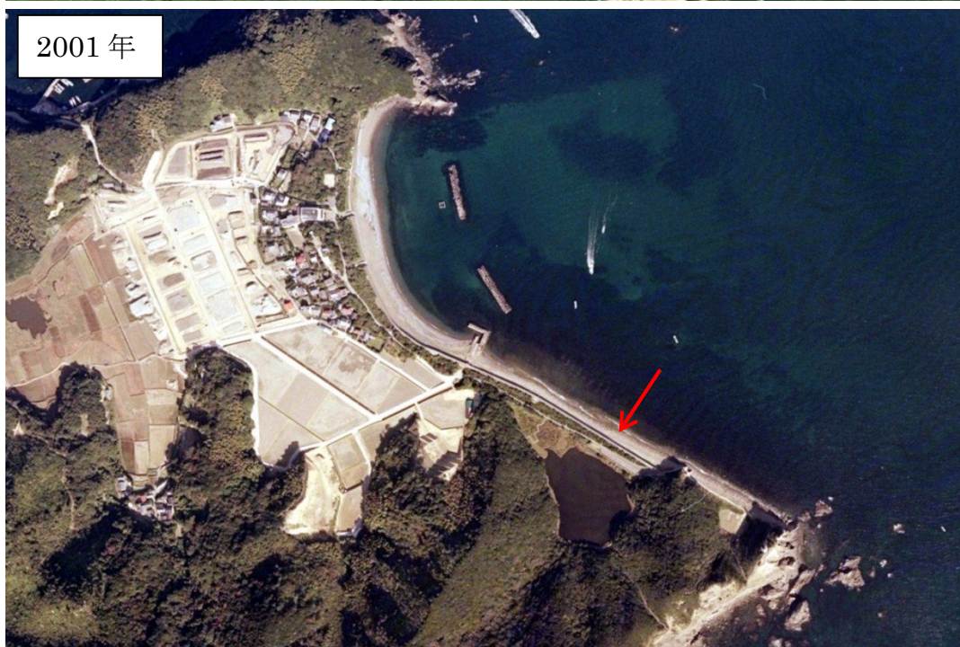
図 4-1 「27 蒲生田海岸」における 1968 年と 2009 年の海岸線の比較；集落の前の砂浜に離岸堤防が設置されている。砂浜の中央にある堤防は拡張されている。2001 年の写真には海岸線に沿って護岸の影と考えられる黒い線がある（矢印の場所）。
