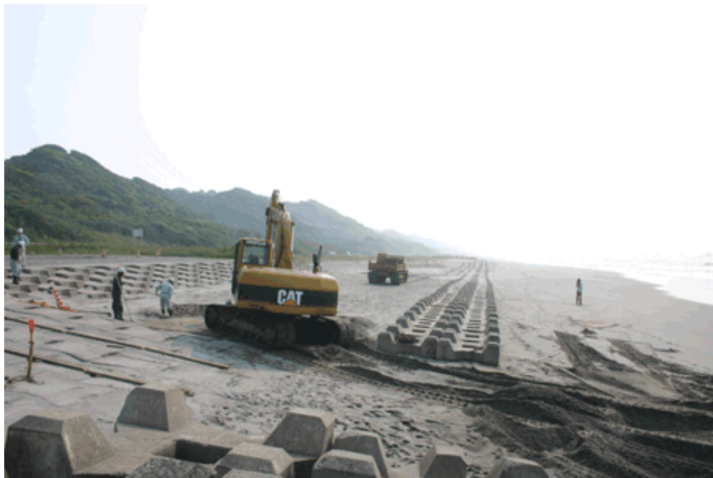
図 2-11 豊橋海岸で行われた消波ブロックの移動作業
