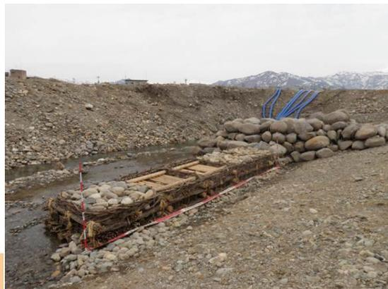
図Ⅱ2-3-40. 粗朶沈床図
