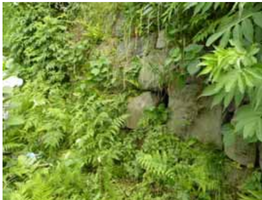
草本が繁茂する石垣
