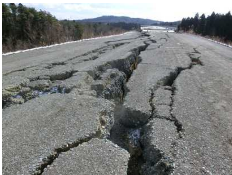
写真2-1 路床面の状況
