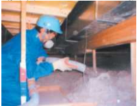
天井の断熱改修
