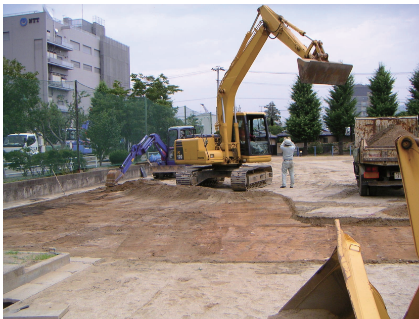
図-2-25：校庭の除染の例（表土の削り取り）
