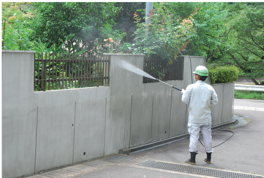
図-2-11：外塀の除染の例（高圧洗浄）
