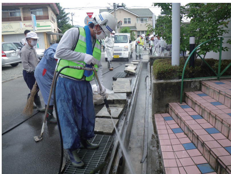
図-2-9：側溝の高圧水除染の例
