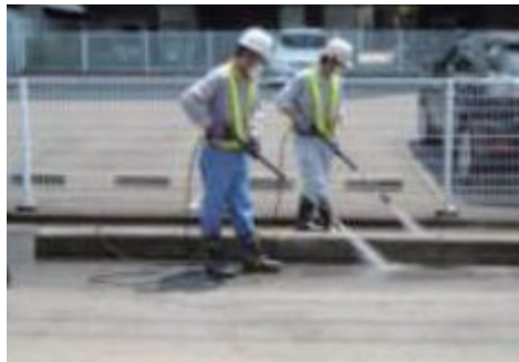
図-2-19 舗装道路の除染の例（高圧洗浄）
