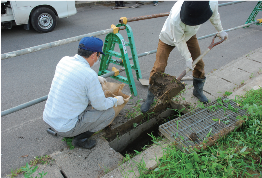
図-2-17：側溝の除染の例（汚泥の除去）
