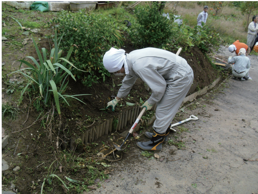
図-2-12：庭等の除染の例（下草等の除去）
