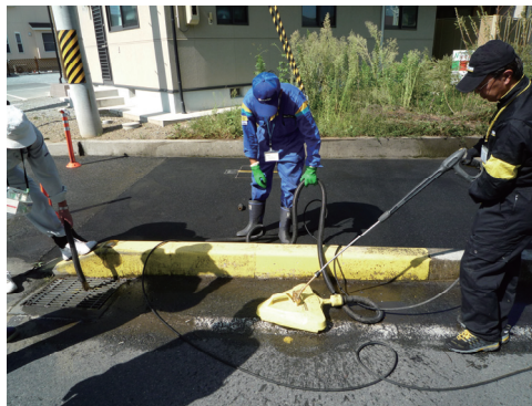
図-2-18：舗装道路の除染の例 （高圧洗浄・排水吸引ブラシによる除染の例）
