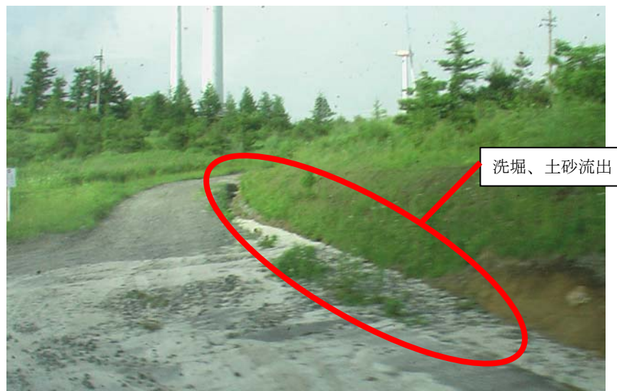
図 7-1 3 道路脇が洗堀されて土砂が流出していた例 29)
