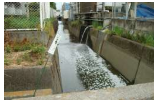
未規制の小規模事業場からの排水状況
