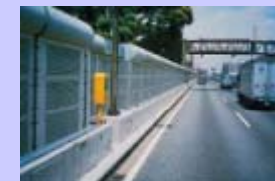
遮音壁の設置
