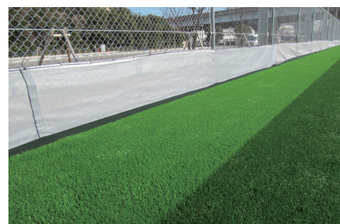
マイクロプラスチック流出を抑制するための対策が採用された人工芝グラウンド
