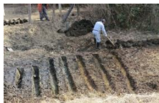
土砂堆積部分の浚渫
